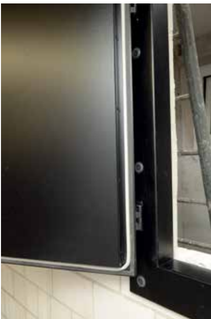
Die umlaufende Dichtung zur Wasserdichtigkeit wird gesteckt (einfacher Austausch anlässlich Tankwartung).
